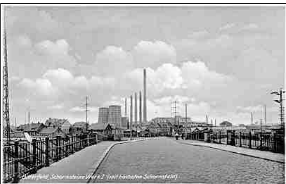
Blick vom alten Eisenbahn-Überbau in Richtung Kraftwerk
