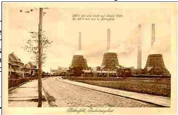
Heutige Elektronstraße, Blick auf das Kraftwerk
